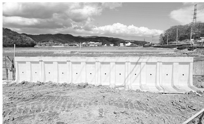
民間造成工事(岡山市東区地内)
