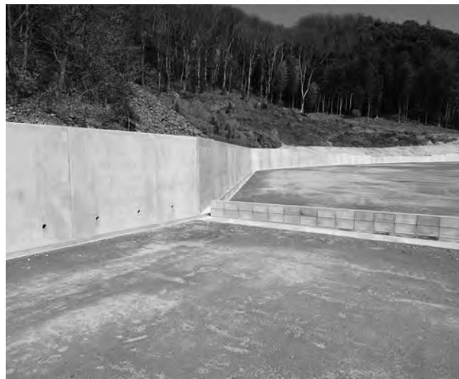
民間造成工事 (笠岡市地内)
