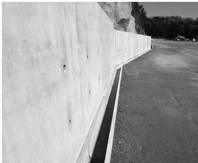
民間造成工事 (笠岡市地内)
