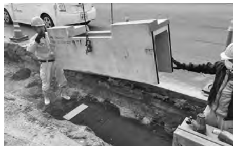
本体据付け状況
