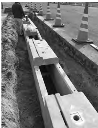
本体据付け完了
