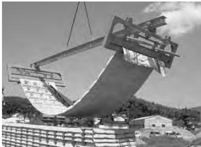
製品荷降ろしは施工用吊り具を用い平坦な場所に仮置きします。
