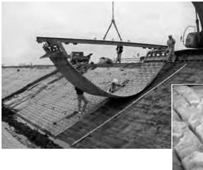
施工用吊り具、施工重機の選定を行い、施工用吊り具を用いて製品を把持し、所定位置に敷設します。必要に応じてアンカーピンを打設します。
