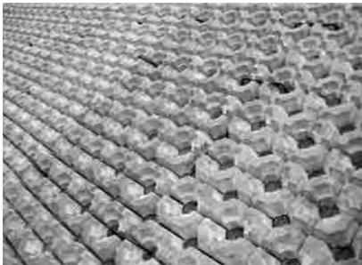
シビックマット敷設後、その上から10~30cm程度の厚さで覆土します。覆土後自然植生を図りますが、積極的に緑化する場合は植生工を実施します。
