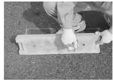
③ブロック底面、アンカー穴、ブロック設置場所の汚れを取り除きます。
