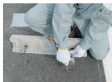
⑥ワンタッチ差筋アンカーをブロック底面の穴に差し込み、ハンマーで打ち込んで固定させます。
