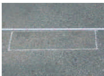
①ブロック設置位置を計測します。
