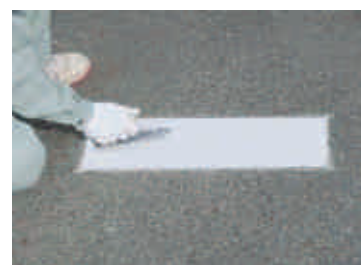
③設置箇所全面に接着剤をコテ塗りします。（厚さ2mm程度まで。厚塗りしますと硬化が遅くなりますのでご注意ください。）
