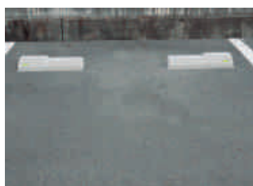
⑤24時間以上養生した後、車止めブロックとして使用していただけます。
