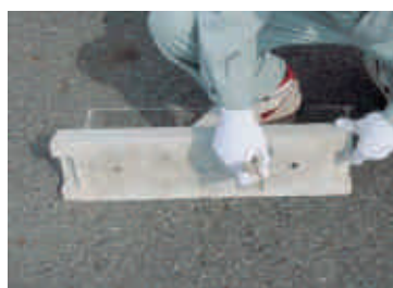
②ブロック底面、ブロック設置場所の汚れを取り除きます。
