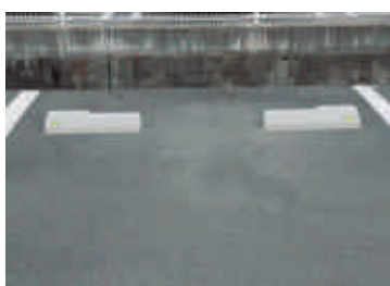
⑧24時間以上養生した後、車止めブロックとして使用していただけます。
