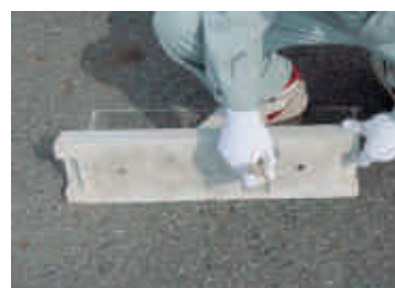
③ブロック底面、アンカー穴、ブロック設置場所の汚れを取り除きます。
