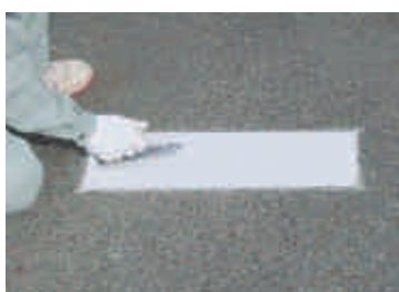
⑤設置箇所全面に接着剤をコテ塗りします。（厚さ2mm程度まで。厚塗りしますと硬化が遅くなりますのでご注意ください。）
