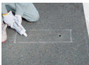
④アンカー穴にグラウトもしくは専用接着剤（ナルシルバー）を充填します。
