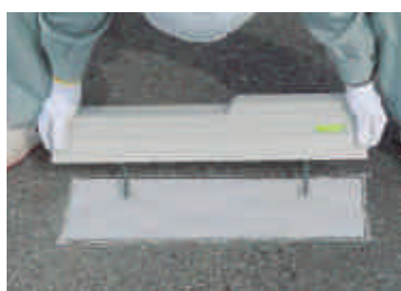
⑦アンカー穴に差筋が入るように調整しながら、ブロックを設置します。
