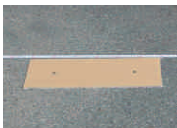
①ブロック設置位置、アンカー穴位置を計測します。
