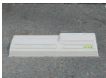
④ブロックを設置します。
