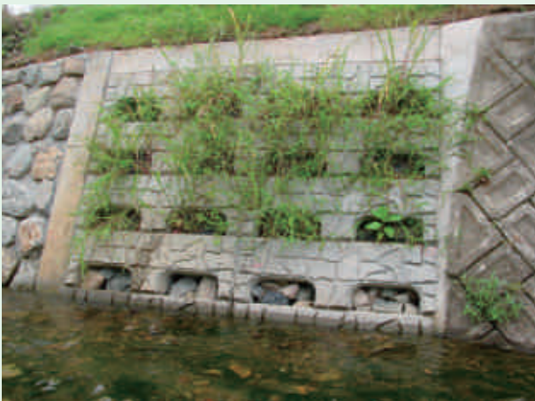
勝英管内 災害復旧工事
