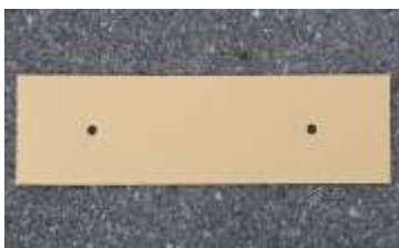
①差筋穴位置ガイド（段ボール）
