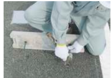
⑥ワンタッチ差筋アンカーをブロック底面の穴に差し込み、ハンマーで打ち込んで固定させます。
