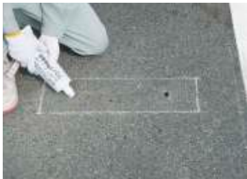
④アンカー穴にグラウトもしくは専用接着剤（ナルシルバー）を充填します。
