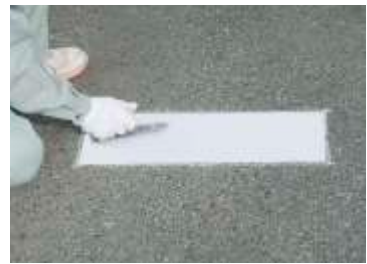
③設置箇所全面に接着剤をコテ塗りします。（厚さ2mm程度まで。厚塗りしますと硬化が遅くなりますのでご注意ください。）
