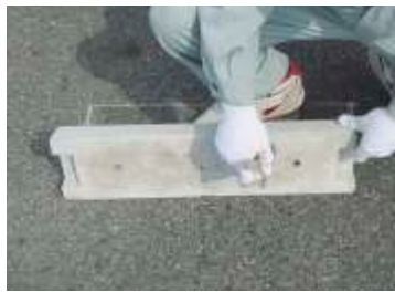
②ブロック底面、ブロック設置場所の汚れを取り除きます。
