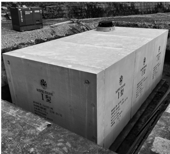
民間造成工事 (岡山市内)
