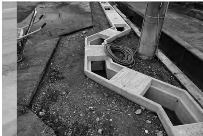
民間造成工事 (岡山市東区藤井)
