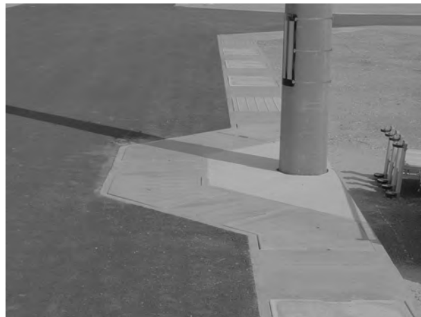
民間工事 (大高地区)
