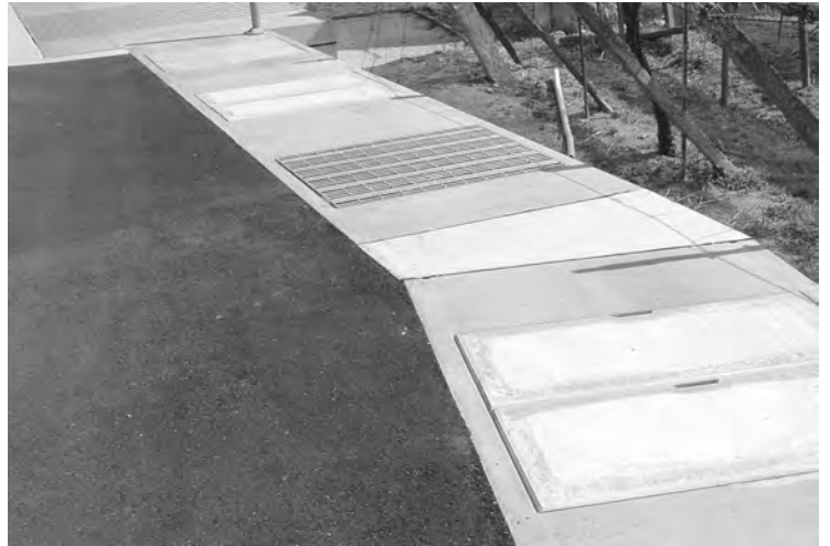
民間工事(谷尻地区)
