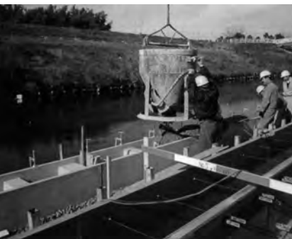
7. コンクリート打設
