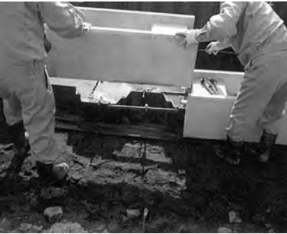
5. 底型枠受けブラケットの取り付け
