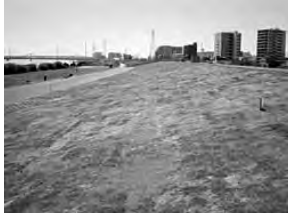
護岸としての高い安定性を確保
